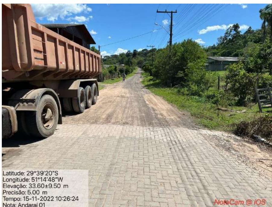
Foto 1: Rua Andaraí - Início do trecho
